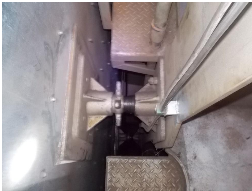
Ilustración 16 Soporte de los tanques de carga situado dentro de los espacios vacios
