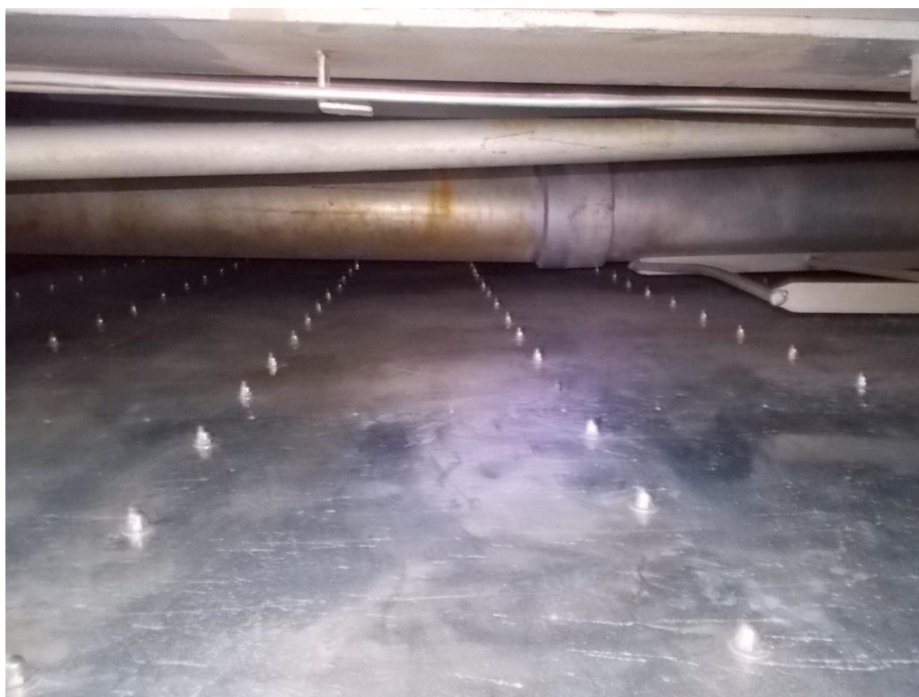
Ilustración 17 Mamparos de los tanques de carga situados en los espacios vacíos
