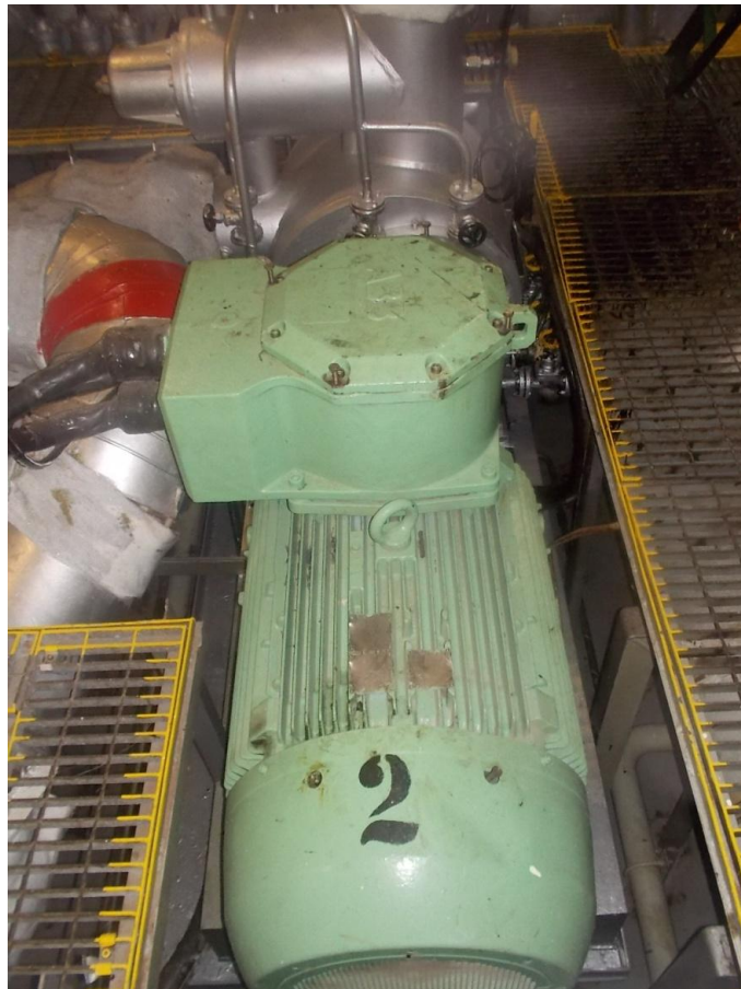
Ilustración 3 Bomba descarga tipo 'tornillo'
