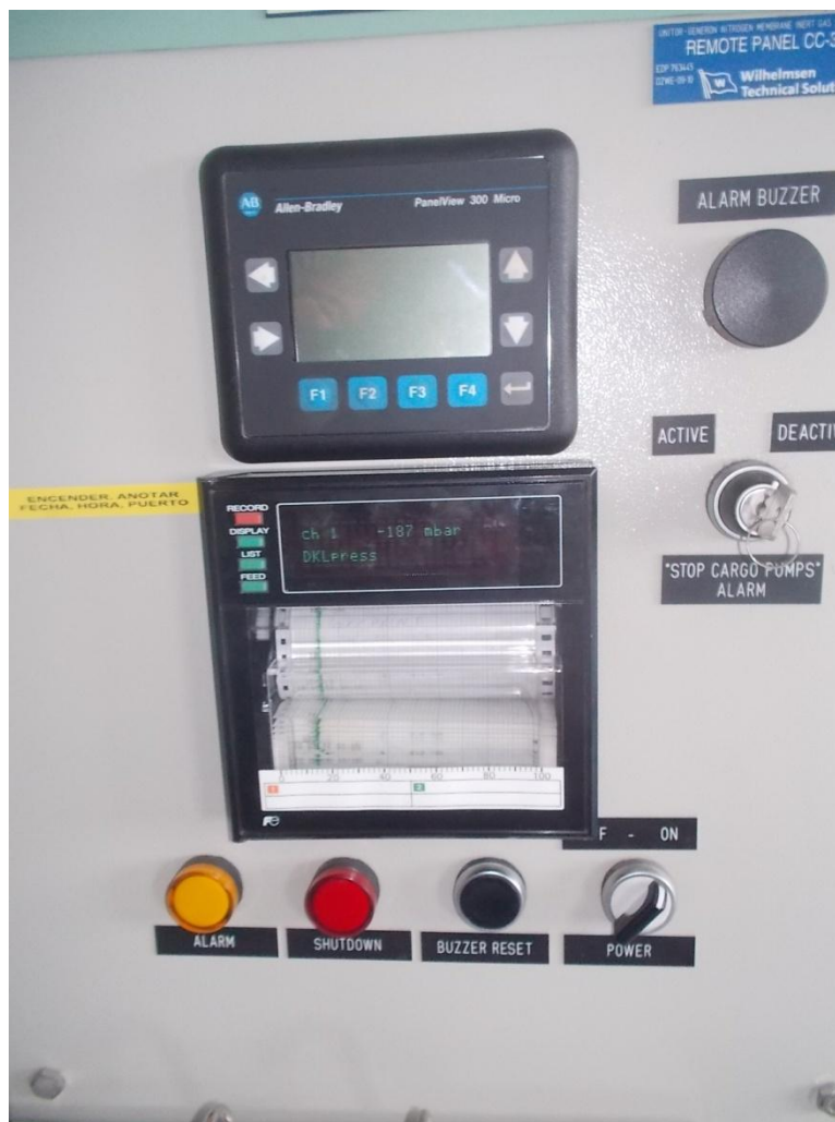
Ilustración 30 Pantala para ajustar el porcentaje de oxígeno del gas inerte
