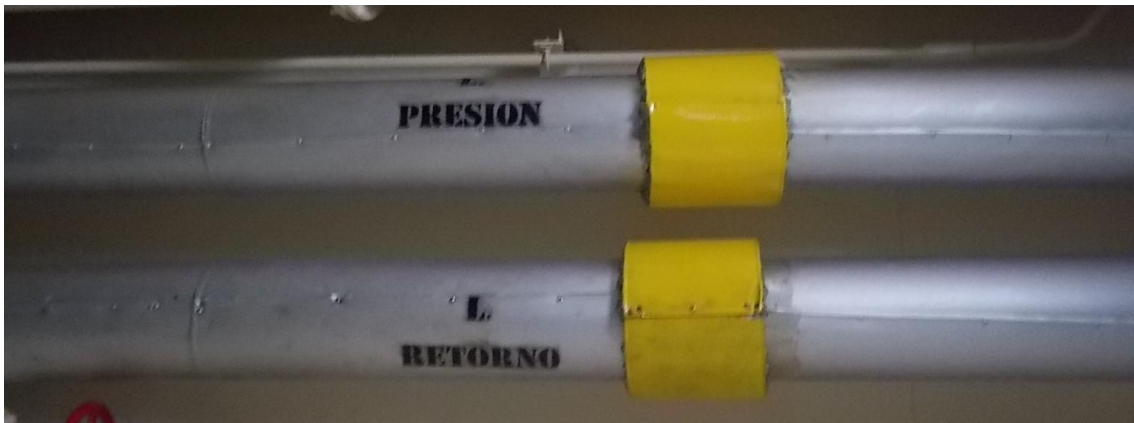
Ilustración 39 Línea de presión/retorno del aceite térmico
