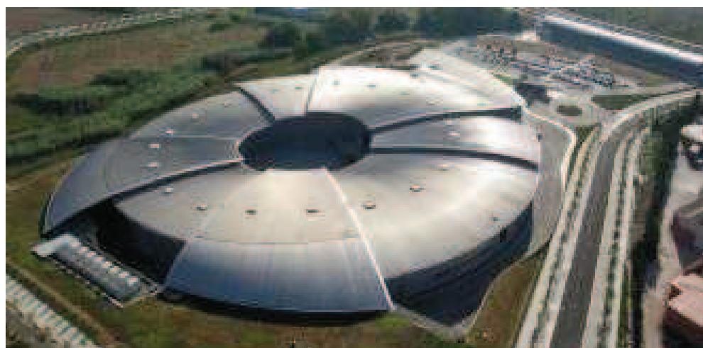
Figura 4.1 Vista aèria del Sincrotró ALBA [1].
