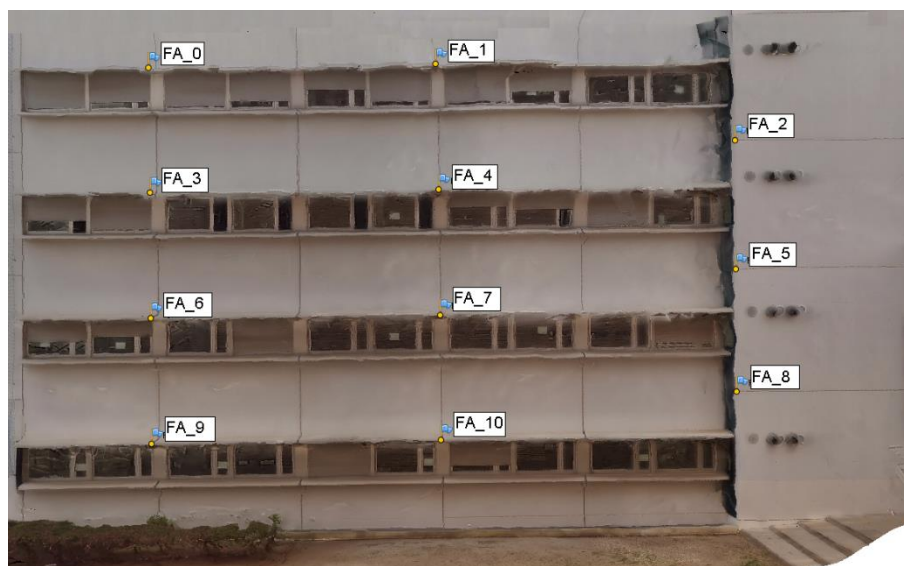
Figura 10 Distribució dels punts mesurats a la façana A.
