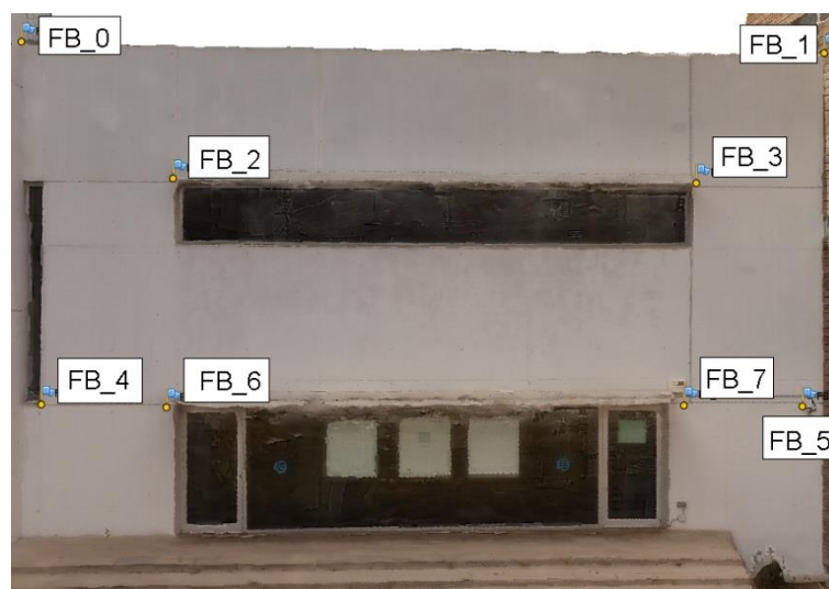
Figura 11 Distribució dels punts mesurats a la façana B.
