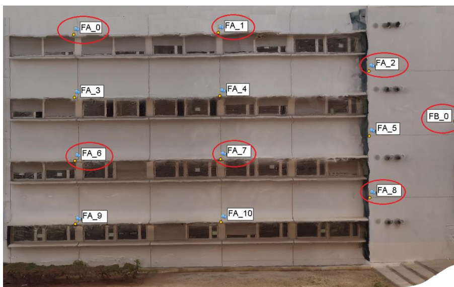
Figura 20 Punts de suport a la façana A.
