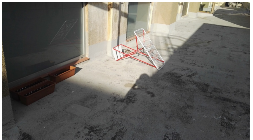
Figura 8: Zona d'un terrat de l'ETSEIB escollida per la realització de l'experiment
