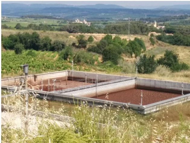
Zona de digestió aeròbica
