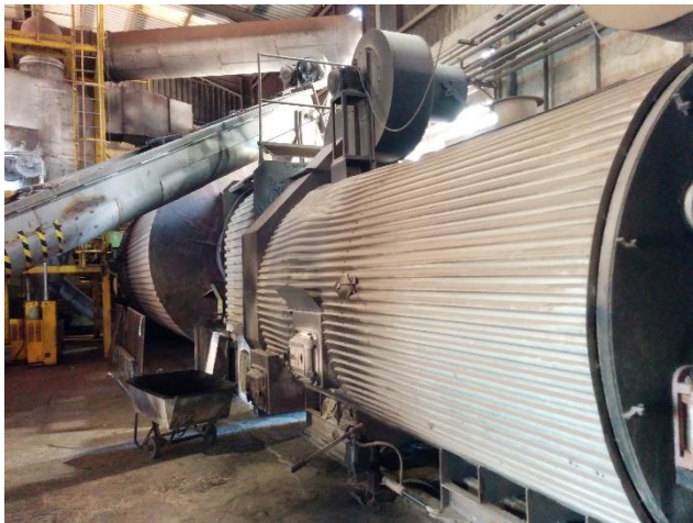
Cambra de combustió i assegador rotatiu
