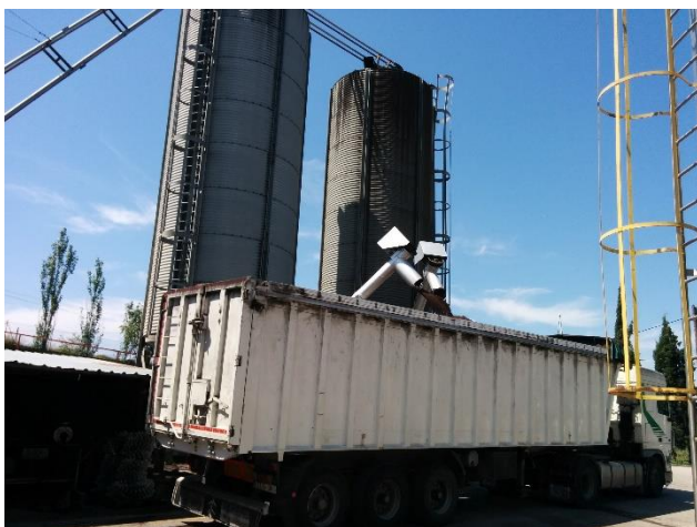
Zona de carga del granet
