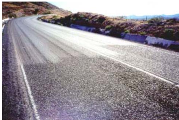
Fig. 3.41. Ejemplo de exposición de áridos en un pavimento flexible 110 .
