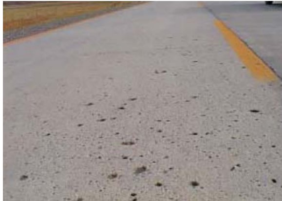
Fig. 3.46. Ejemplo de baches en pavimento rígido 114 .
