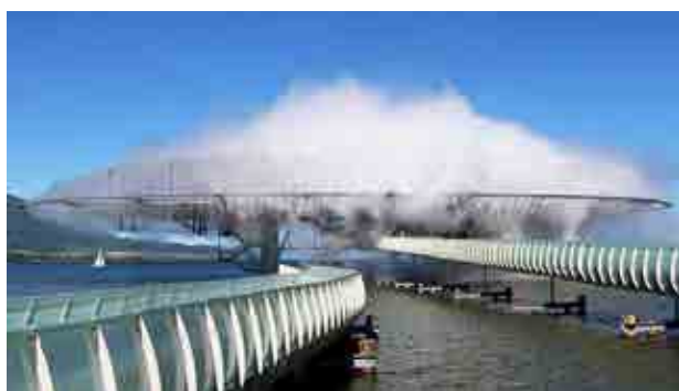
Figura 27A-Vista de la instalación desde pasarela (Instalación Blur).
