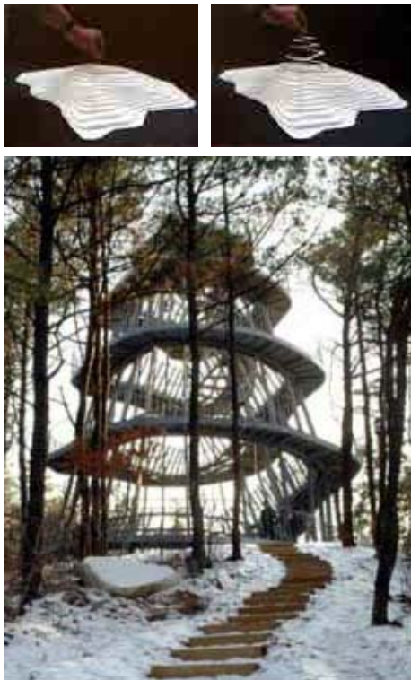
Figura 40 – Una trayectoria vertical delimitadora; vista de torre de observación (Instalación Bigger).
