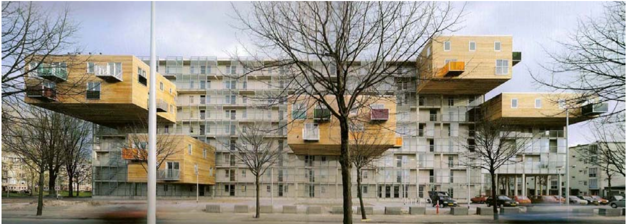
Figura 43 – Transparencia de la diversidad tipológica interior y lectura del volumen a través de un espacio intermedio; fachada Norte (Apartamentos Wozoco's).
