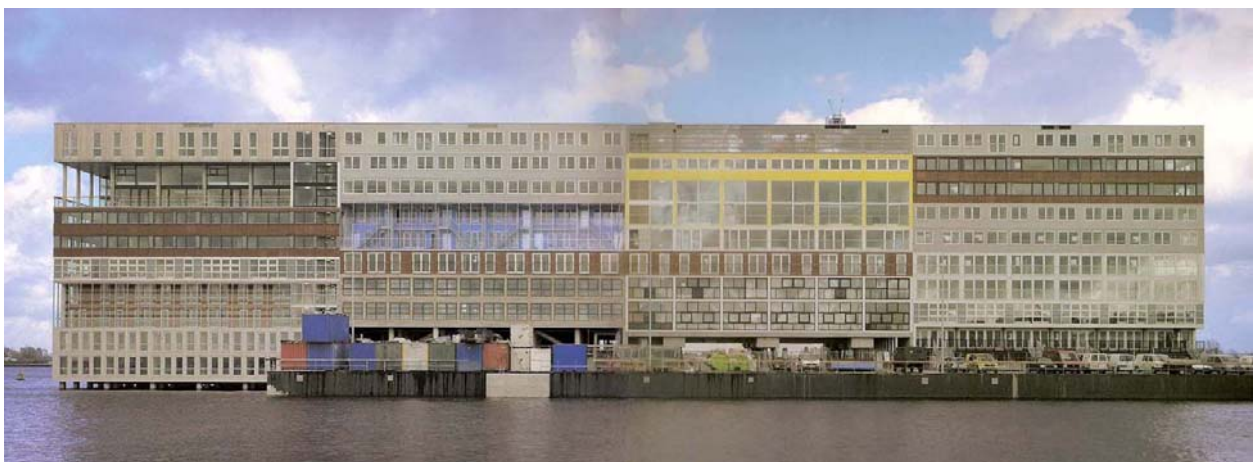
Figura 3 – Transparencia de un apilamiento tipológico; alzado desde el mar (Edificio residencial SILODAM).
