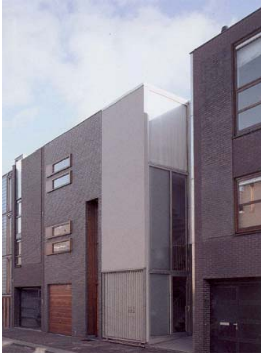
Figura 48- Un límite cercado por un espacio implícito; fachada vivienda 12 (Dos viviendas en Borneo-Sporenburg).
