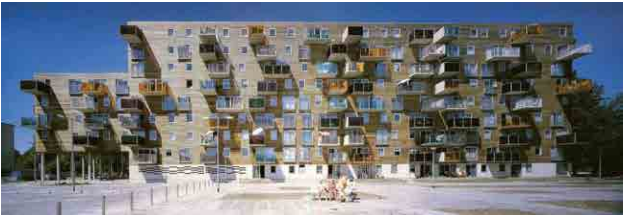
Figura 46– Transparencia de la diversidad tipológica interior; fachada Sur (Apartamentos Wozoco's).
