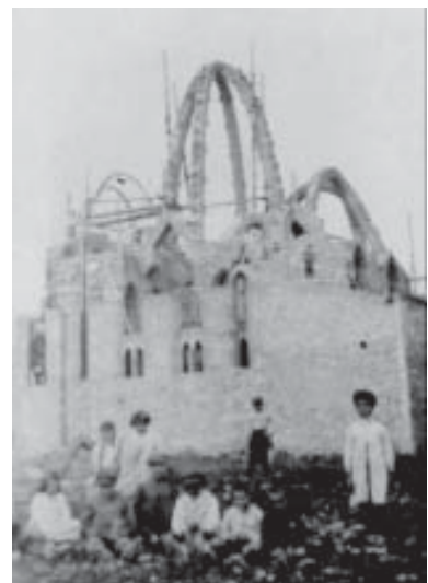
DG-239. Imagen de las obras. Arcos parabólicos principales terminados. Cimbra de los arcos que cubren la capilla del Roser, 1919-1922.
