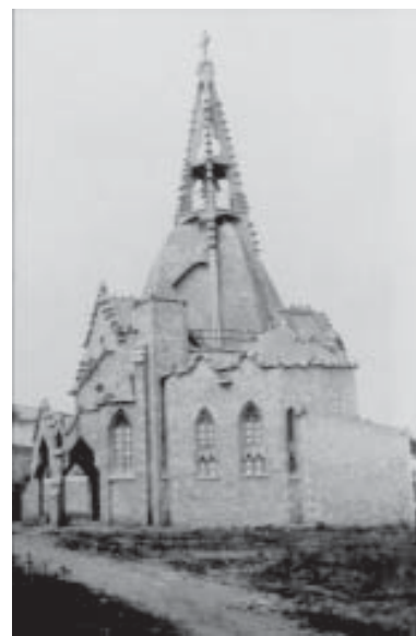
DG-243. Imagen desde el suroeste de la iglesia ya terminada, 1923.
