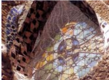
Cripta de la Colonia Güell, 1908-1914. Detalle de las rejas hexagonales fabricadas con las agujas de los telares.
