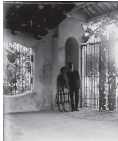
Rejas en un pórtico de la Casa Negre en Sant Joan Despí, 1915-1926.
