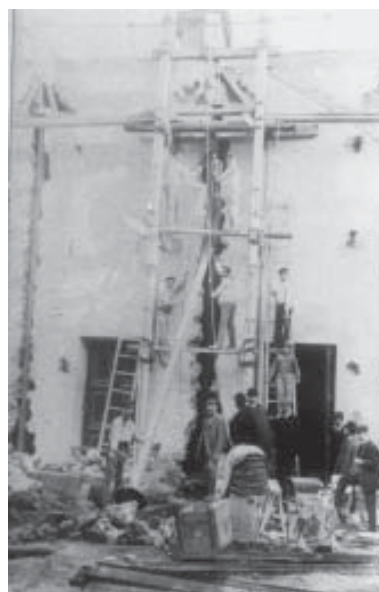
Teatro del Patronat Obrer, 1908. Instalación de uno de los pilares reutilizados.
