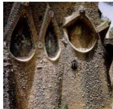
Cripta de la Colonia Güell, 1908-1914. Conjunto de aberturas.
