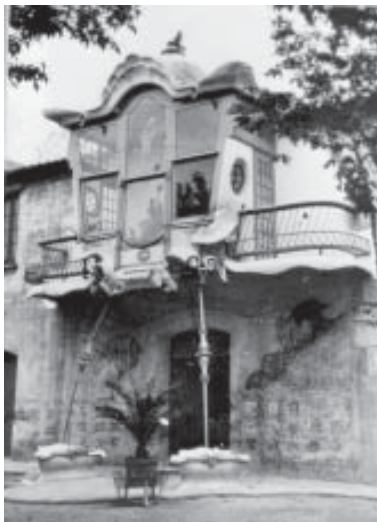
DG-152. Tribuna recién terminada. En esta imagen puede comprobarse que el coronamiento aún no se ha construido.
