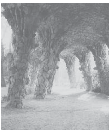
Viaducto inferior del Park Güell. 1901-1903.
