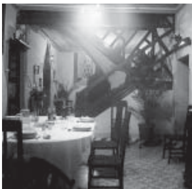
DG-165. Cuerpo de la escalera en planta baja. Vista desde el comedor.
