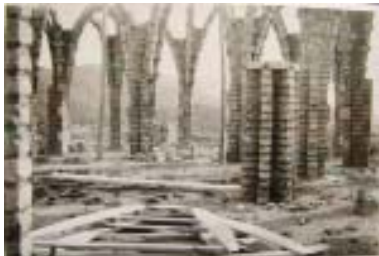
Imágenes del Santuario de Montserrat en construcción. 1926-1929. Montferri (Tarragona). DG-324, DG-328 y DG-325.
