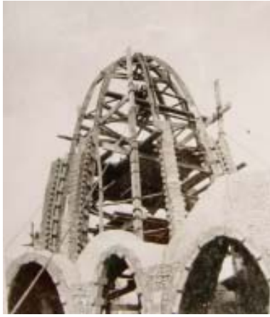
Bóveda principal del Santuario de Montserrat en construcción. 1928-1929. Montferri (Tarragona). DG-331.
