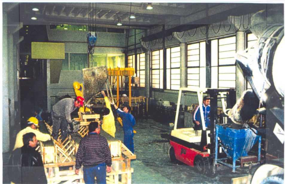
Foto 4.- Hormigonado de las vigas. El hormigón fue transportado en camión hormigonera y puesto en obra mediante cubilote.
