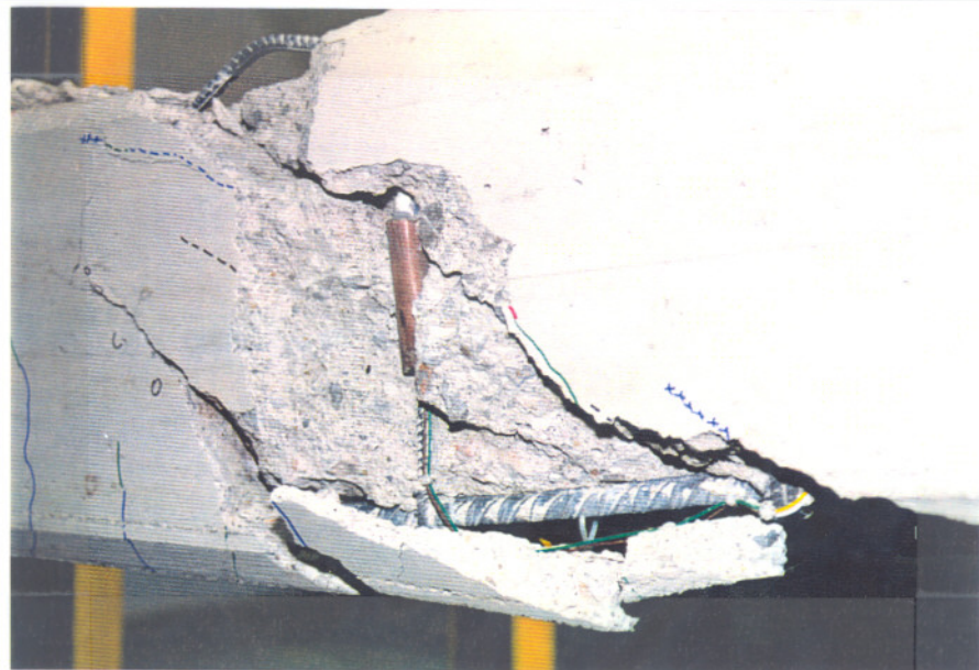
Foto 31.- La viga R21 rompió por el extremo instrumentado a cortante. Con la rotura se produjo el desprendimiento del hormigón que recubría la armadura traccionada. También pandeó la armadura comprimida.
