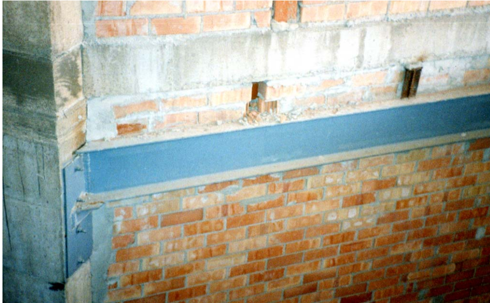
Figura 5.22 Viga de acero con la que se refuerza la escalera de la sección del edificio FU analizada.
