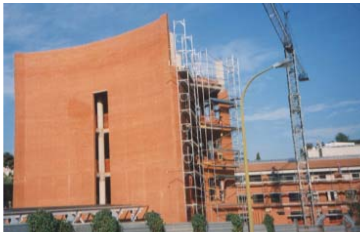
Figura 5.20 Fotografía de una sección del edificio FU durante la etapa 3 de su construcción.
