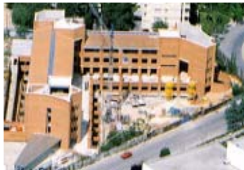
Figura 5.18 Fotografía del edificio FU ya terminada su construcción.
