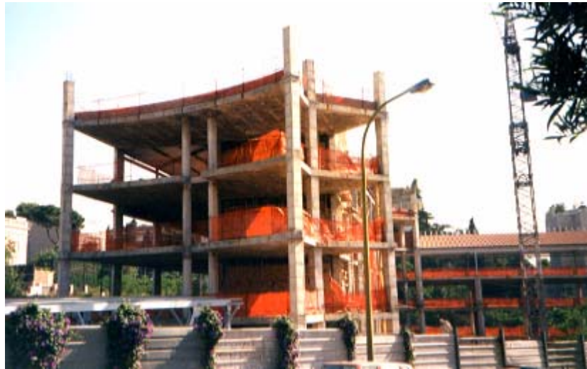
Figura 5.19 Fotografía de la estructura del edificio FU (etapa 1)
