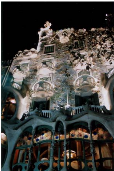
Foto 31. Casa Batlló de Antoni Gaudí, diseñada y construida entre 1904 y 1906. En ella se refleja la gran calidad artesanal de su trabajo, se observa el uso de la piedra natural y de piezas cerámicas de diversos colores. En esta obra, al igual que en otros de sus edificios se destaca la importancia que da a la relación con las formas naturales y orgánicas. Fuente: K. Simancas Y.
