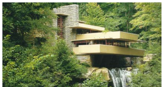
Foto 38 y 39. Fotos de día y de noche de la casa de la cascada de Frank Lloyd Wright, 1936. Fuentes: Sudjic y Beyerle, 2000, p.47 y Behling y Behling 1996, p158.
