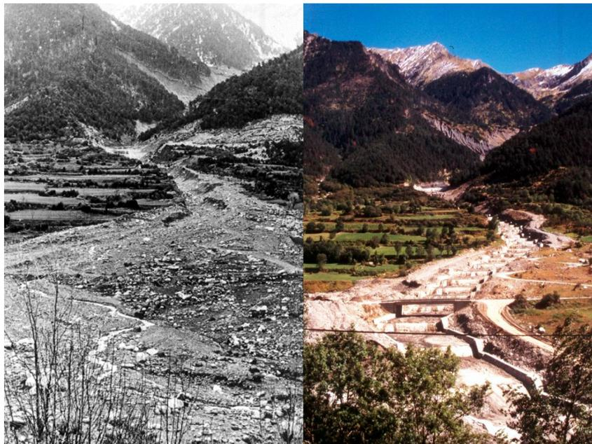
*Figura 20: Cono del barranco de la Baixada de Senet antes y después de los trabajos de canalización y de construcción del puente de acceso. (Fuente: San Roman, 2010).*
