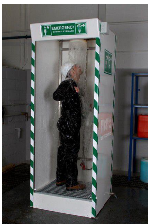
Figura 4.2. Exemple de dutxa de descontaminació
