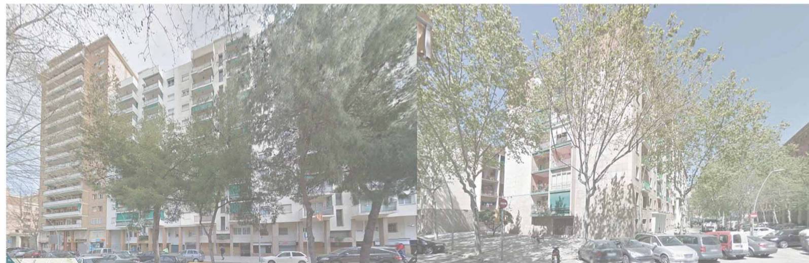
Façana carrer Concili de Trento
