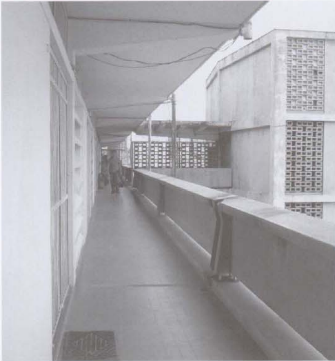
LUANDA, EDIFICIO CIRILLO, PINTO DA CUNHA, 2011
