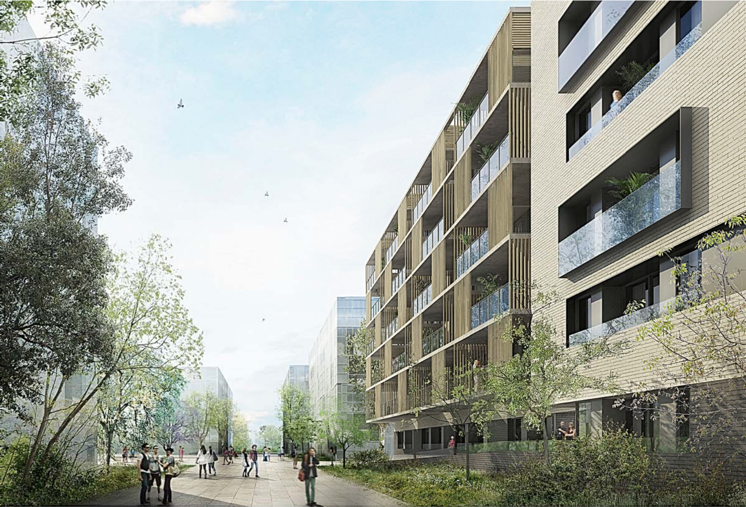
V2 L'ACCÉS EN RAMPA
