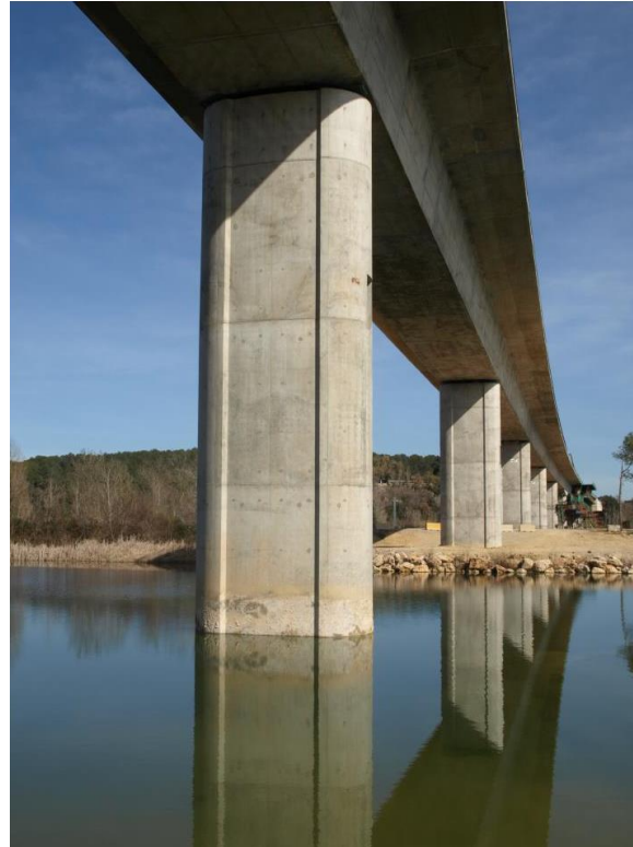
Figura 3-1- Viaducto sobre el río Fluvià en la actualidad
