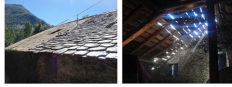
TAULELLES DE RECOLZAMENT DE LA PISSARRA HUMITS I PODRITS A LA CARA EXTERNA; ENNEGRITS PELS FUMS DE LA XEMENEA A LA PART INTERNA
