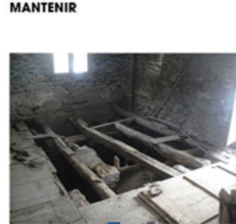
BIGUES I BIGUETES DE FUSTA DE FORJATS INTERIORS HAN PATIT GREUS DEFORMACIONS. L'ATAÇ DELS CORCS HA DEBUTAT LA SEVA SECCIÓ. TAMBE ES MANIFESTA UNA REDUCCIÓ DE LA SECCIÓ EN EL CAP DE LES BIGUES PRINCIPALS.
