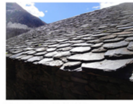
TEULADA DE PISSARRA DETERIORADA PER L'ACCIO I LES INCLÈNCIES DEL TEMPS REAPROFITAR
