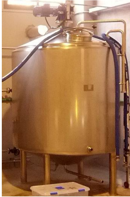
Figura 32. Depósito de maceración – cocción. Fuente: http://ingenieriacervecera.weebly.com/
