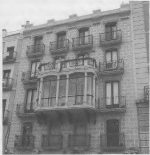
Façana de la casa Boxó, edifici d'habitatges a la Rambla Nova Tarragona, núm. 41. Fotografia de l'autor.
