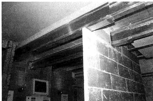
Foto 11.—Los sistemas telescópicos son también fáciles de transportar y de montar.
