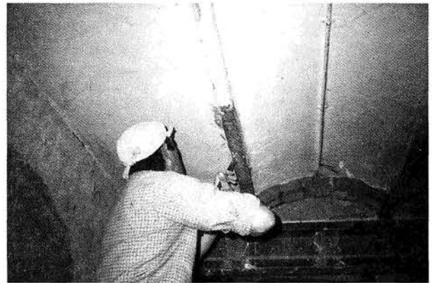
Foto 4.—Reparaciones puntuales como ésta se pueden hacer cuando los problemas están muy localizados y con viguetas armadas.
