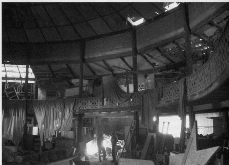
Dos imágenes del interior del Teatro Circo Apolo. (Vilanova i La Geltrú, Barcelona)
