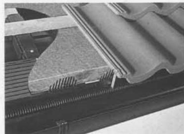
La ventilación permite la eliminación del vapor de agua que atraviesa el forjado de la última planta, además de asegurar un buen comportamiento térmico de la cubierta en verano.
