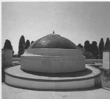
58 y 59. La cobertura de las estructuras de bóveda es un problema constructivo latente, sujeto aún a un interesante campo experimental donde se simultanean las soluciones con materiales amorfos, chapas y escamas de lajas.
