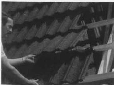
Las chapas metálicas conformadas, de dimensiones 1,33 x 0,45 m, se utilizan a menudo como revestimiento de cubiertas debido a su rápida colocación (fuente: Polytuil Decra®).
