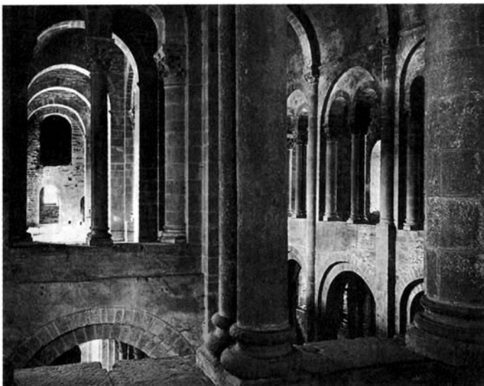
El gruix i la constitució dels murs és complex i divers en funció de les necessitats de cada secció: arcs, voltes, columnes, lesenes, capitells i arquivoltes en el transsepte i la nau central de la Santa Fe de Conques.
