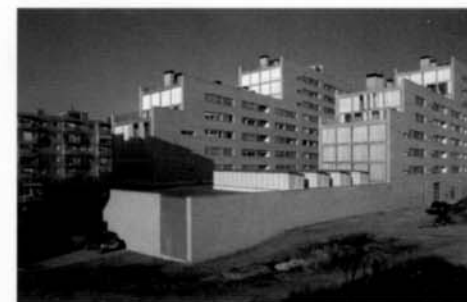
Edifici ronda Europa.
