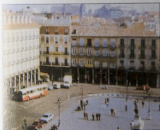
El edificio de Chueca antes de las últimas transformaciones.
