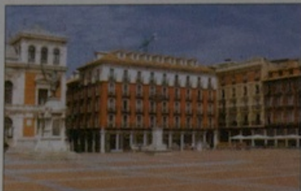
Vista general actual.
