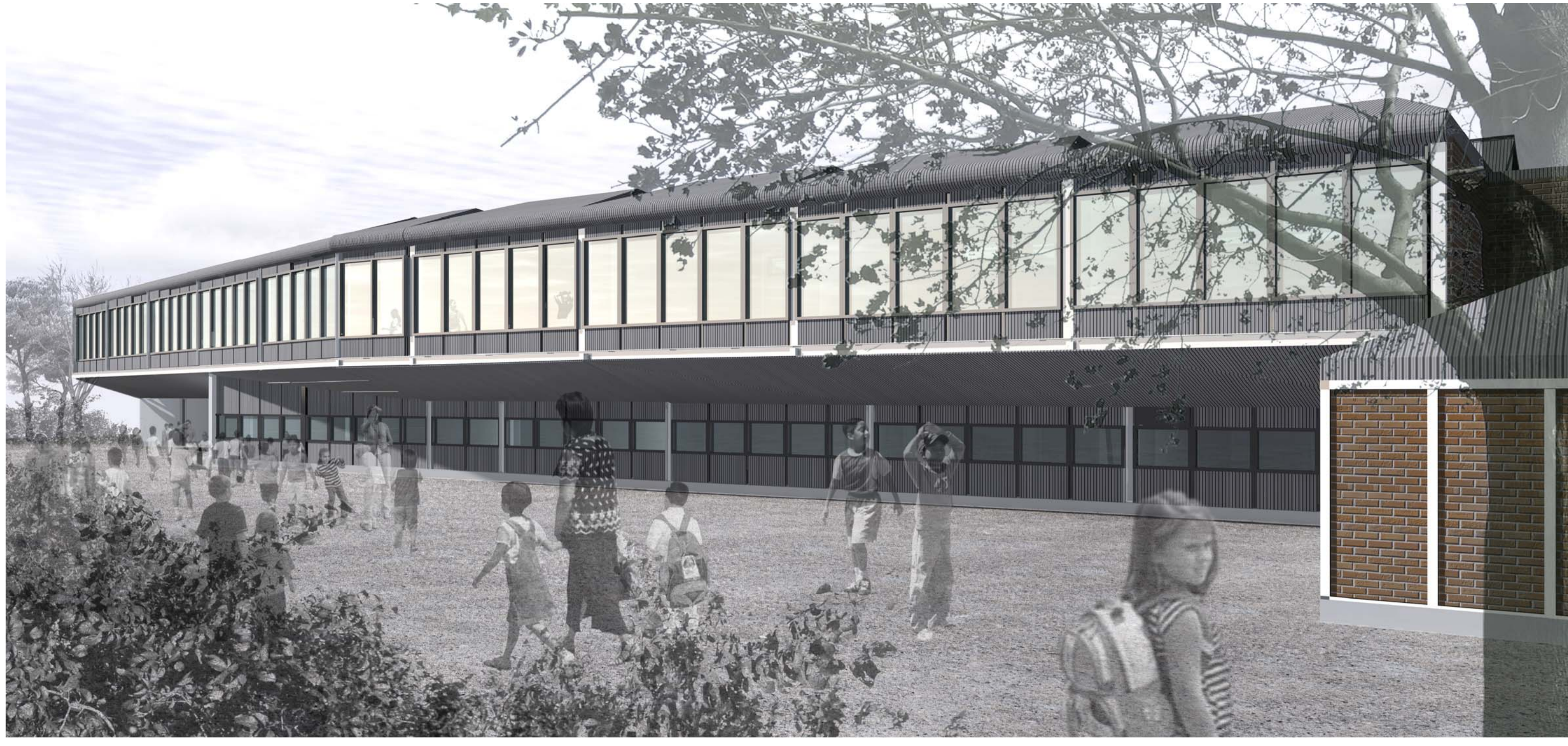
EL PATIO DE PRIMARIA: A LA DERECHA EL BLOQUE DE SERVICIOS CON PANEL PREFABRICADO DE LADRILLO
