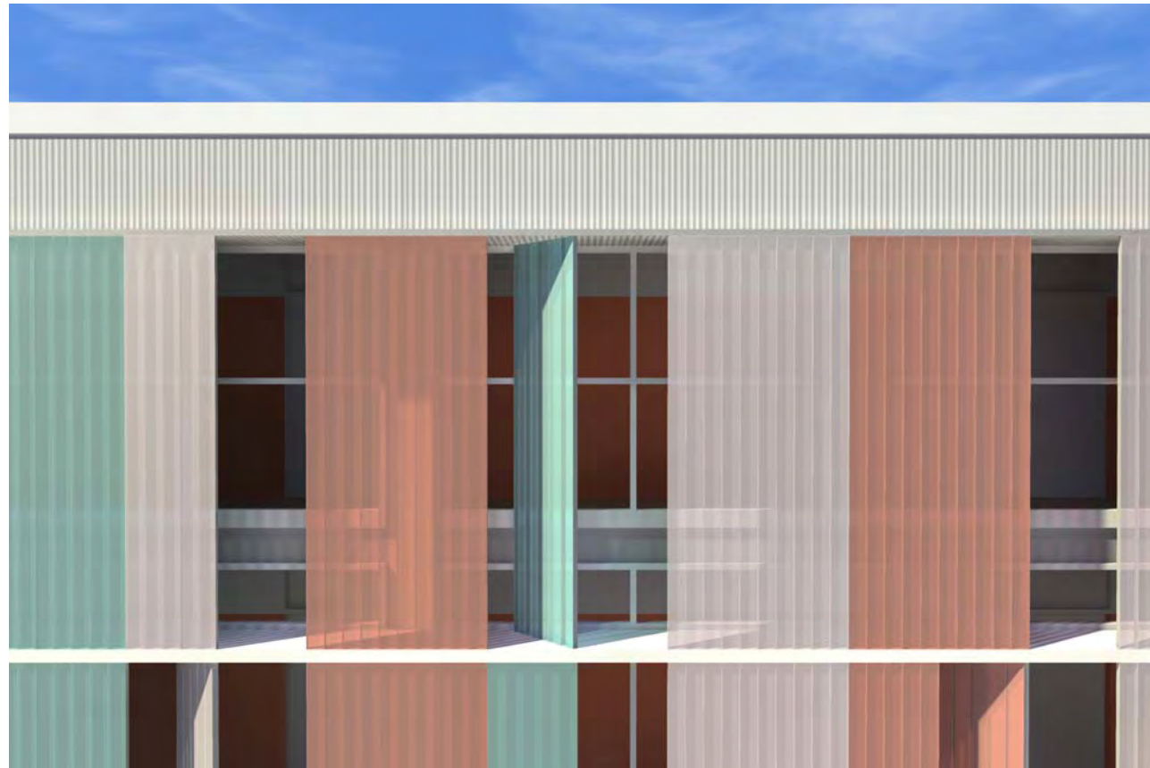
PANELS DE POLICARBONAT CEL·LULAR. PROTECCIÓ SOLAR
