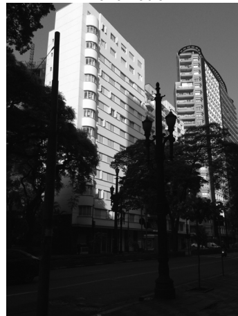
Figura 2. Fachada actual del Edificio María Paula
