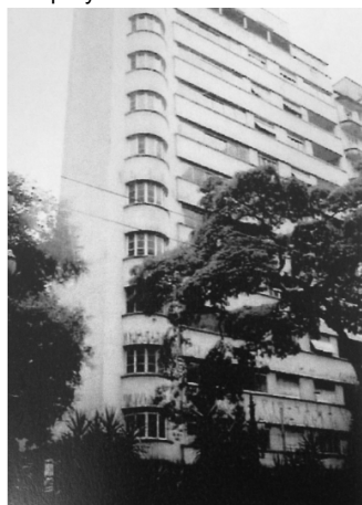
Figura 1. Fachada del Edificio María Paula, antes del proyecto de rehabilitación
