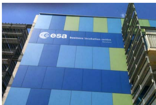
Edifici RDIT del Parc UPC, al Campus del Baix Llobregat de la UPC
