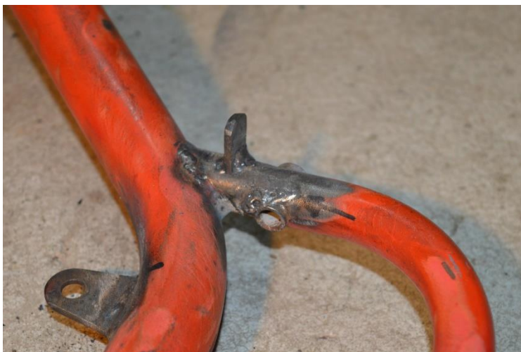
23: Instal·lació d'un suport pel pedal i reparació de l'orifici on va collat (Font: Foto pròpia)
