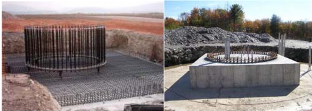
Figura 5.3. Vista de la cimentación
