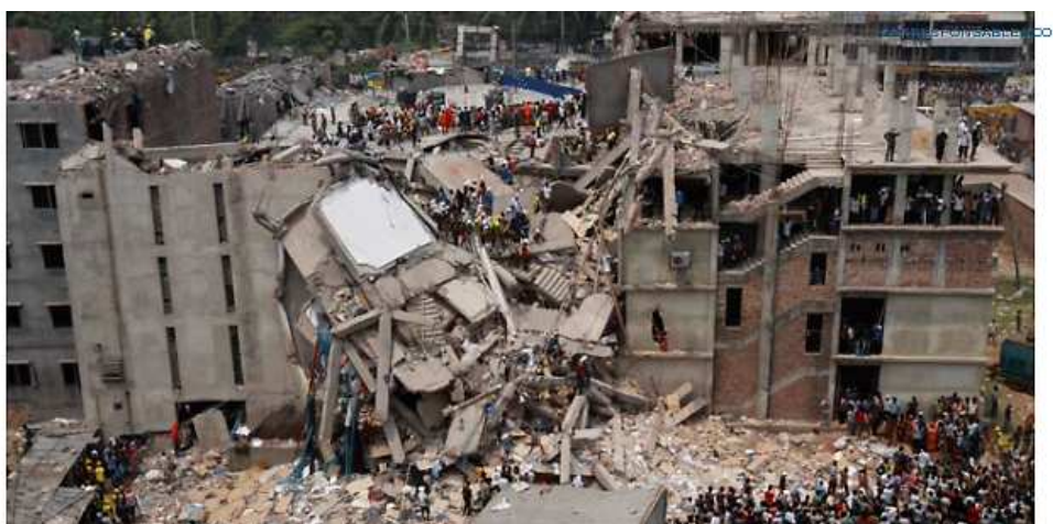
Figura 12. Derrumbe del edificio textil en Savar, Daka, Bangladesh (44)
