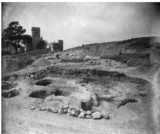
Imatge de les excavacions realitzades l'any 1930 (ANC-FB)
