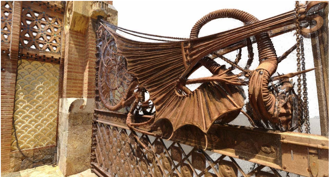
Projecció RGB sobre el model de núvols de punts
