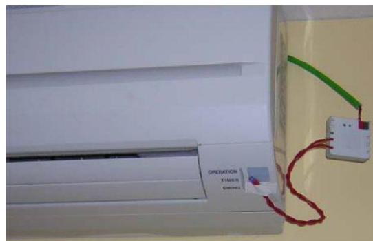
Imagen 48: Montaje controlador zennio y split
