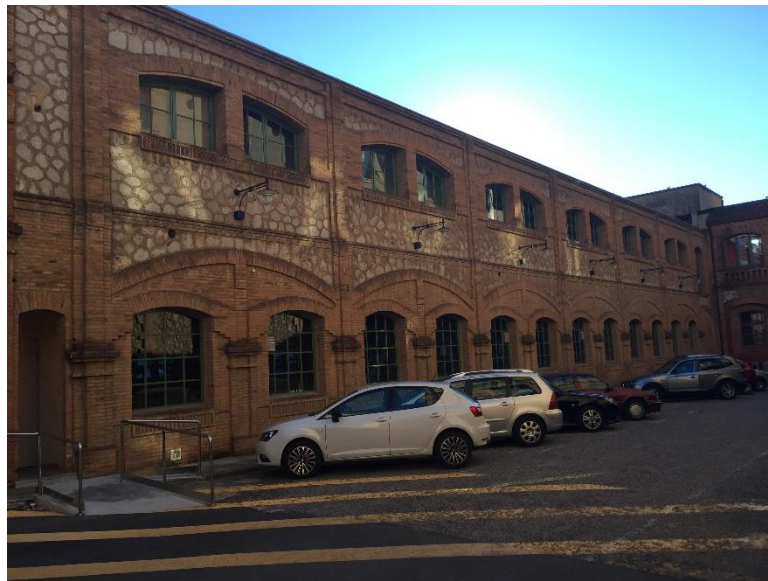
Figura 12. Façana orientada al nord
