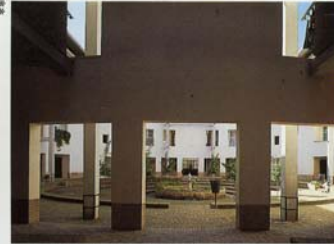
■ Acceso al patio de manzana B 2 .
