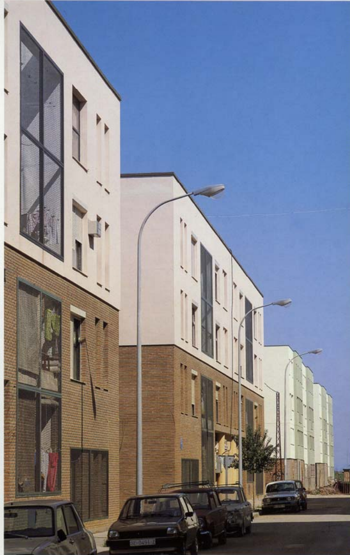
■ Fachada de las dos manzanas A 1 , al fondo las dos manzanas.
