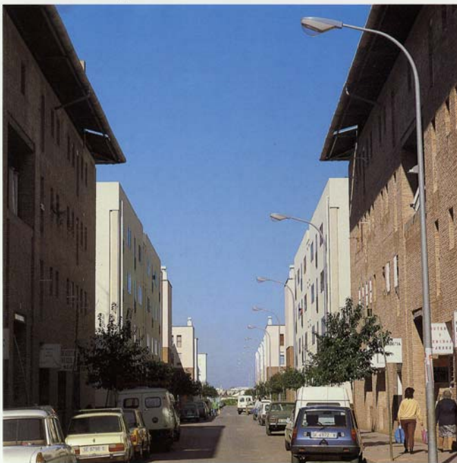
■ Calle central de la 1ª Fase de construcción del polígono.
