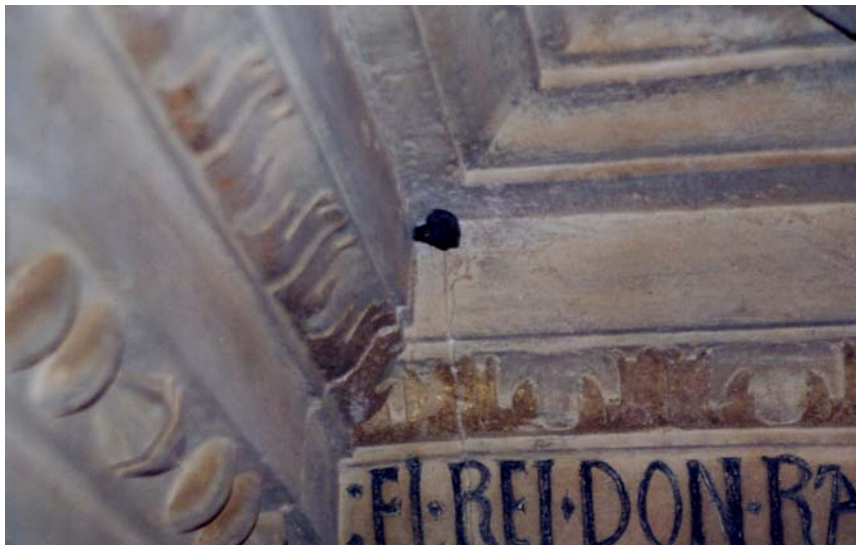
Figura 12. Restos de dorado con pan de oro, bol rojo y colores verde y azul en la moldura del nervio. Leyenda con calcita, albayalde y carbón vegetal. Veladura original de consolidación, protección y entonación cromática
