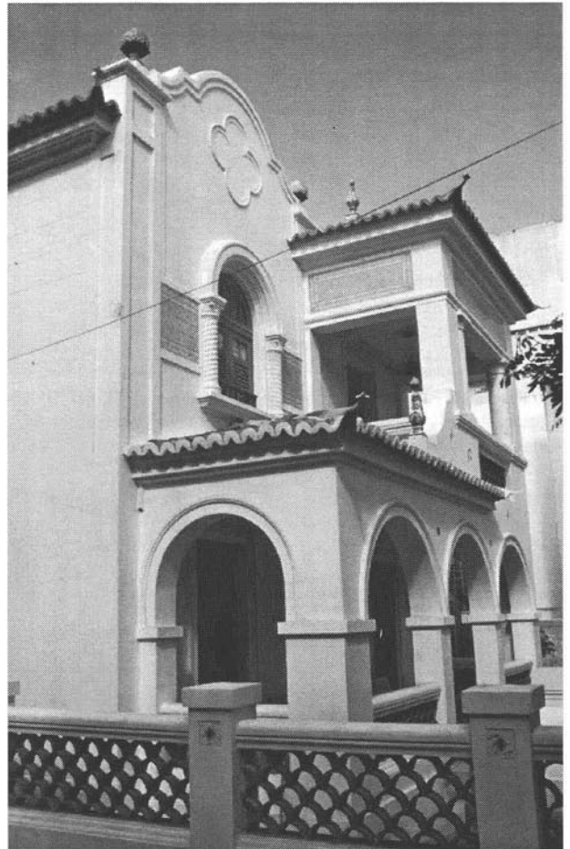
Fachada de casa Neocolonial en Recife, 1926. Los ornamentos neocoloniales están basados en amplios levantamientos hechos en la arquitectura colonial de todo el país.
