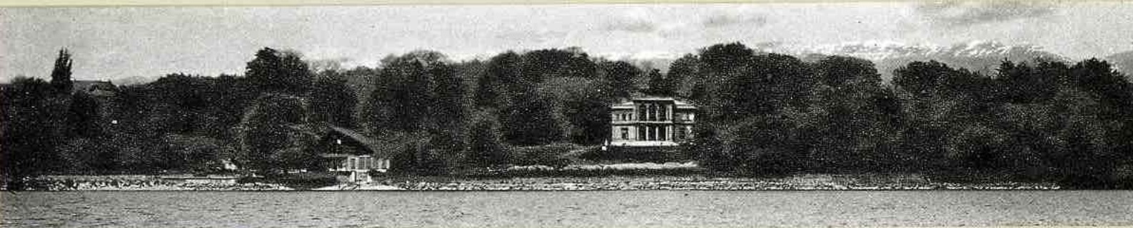
Photographies d'ensemble de la partie du Terrain, contiguë au lac. Vue prise du lac.
