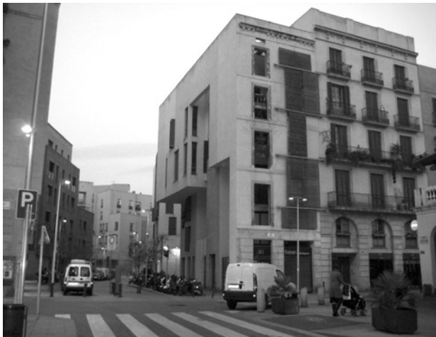
Foto 1. Fachada de la Vivienda de Protección Oficial Cambó 2, esquina de avenida de Francesc Cambó con Giralt el Pellisser. Fuente: Salcedo, 2009.
