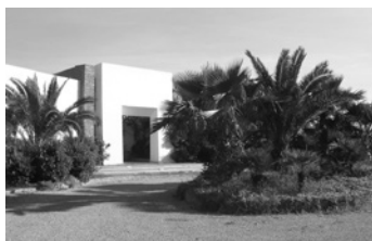
Fig1. Entrée maison Ben Abdelkader vue de l'extérieur.
