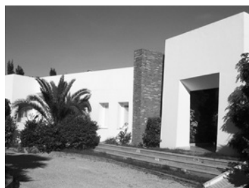
Fig3. Entrée maison Ben Abdelkader vue de l'extérieur.
