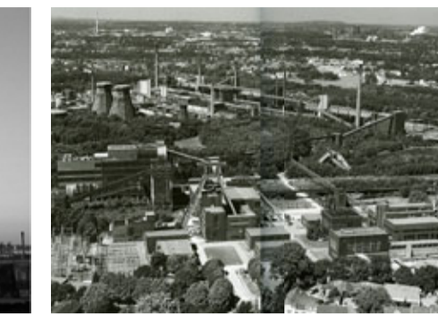
Zeche Zollverein Lloc: Essen, Alemanya Autors: OMA/ N.Foster/ SANAA Execució: 2001-2010
