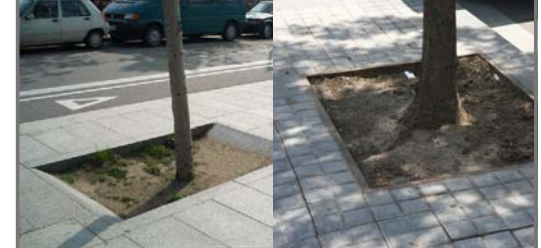
ESCOSELL RAMBLA DE LA CASA ESCOFET DISSENY DE J. ARTIGUES & P. CABRIERA, AQUEST ESCOSSELL I EL PAVIMENT ES DISPOSARIA A L'INTERIOR D'ILLA ESCOSELLS I PANOTS EXISTENTS A LES VORERES. LA RESTA DEL PAVIMENT SERIA FORMIGÓ LUSCAT
