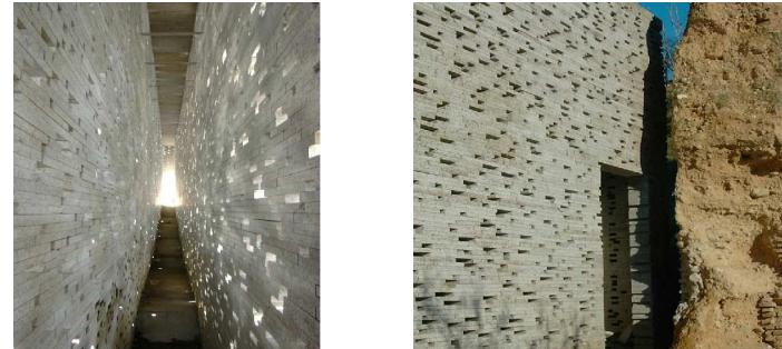
L'objectiu de la rehabilitació va ser restituïr una part de la muralla destruïda a causa d'un moviment sísmic en el s.XIX. La construcció s'ha montant deixant espais oberts per on es perd la llum i la mirada.
