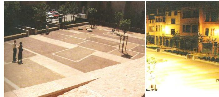
El projecte forma part del pla de millora del casc antic. El projecte es proposa fer més atractiva aquesta zona. Per tal de portar-ho a terme es construeix una connexió transversal, que acaba amb un mirador que contempla la plaça. Aquesta pavimentada amb arena compactada i tires de formigó imitant el parcel·lar original el qual està substituït.
