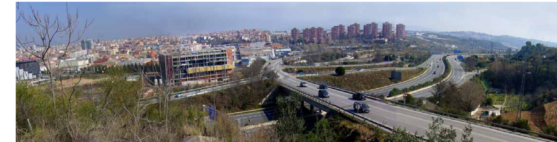
panoràmica 3 (amb les obres dels nous Julgats)
