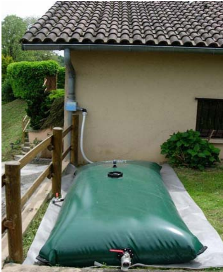
Figura 12. Depósito flexible de poliéster/PVC de 4 m 3 en vivienda unifamiliar. (Solumed)
